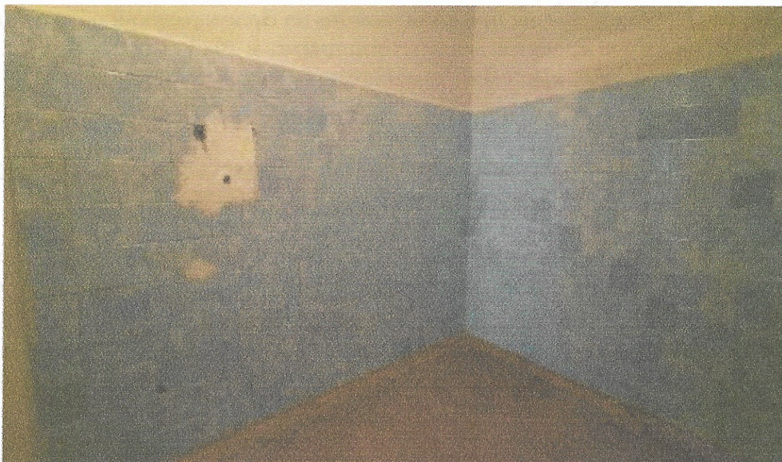
Рис. 1 Состояние объекта «До».
